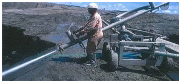
Figure 5 : Surveillance à eau ou lance hydraulique sur roues (Ausenco, 2016: 70)
