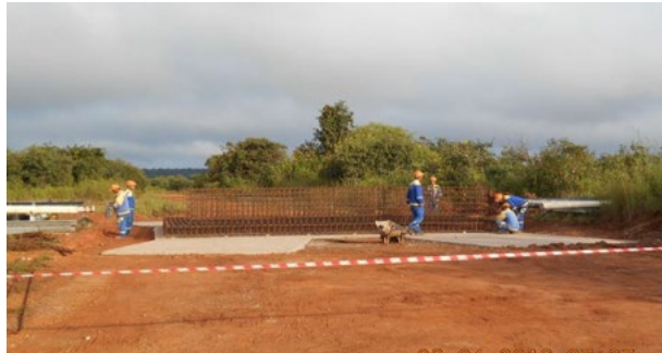
Travaux sur le site 6 de l'usine à chaux
